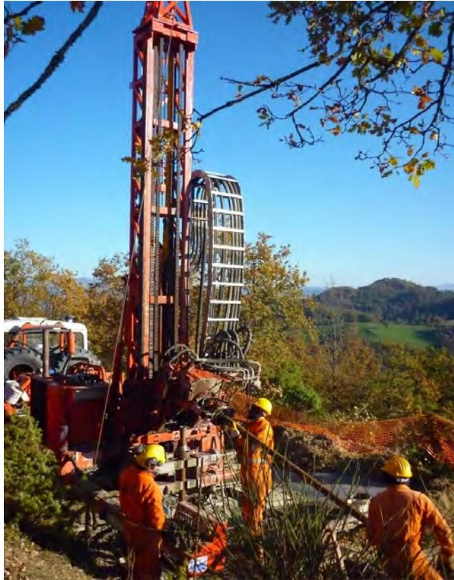
*Perforazione di un pozzo per sismometro borehole.*
